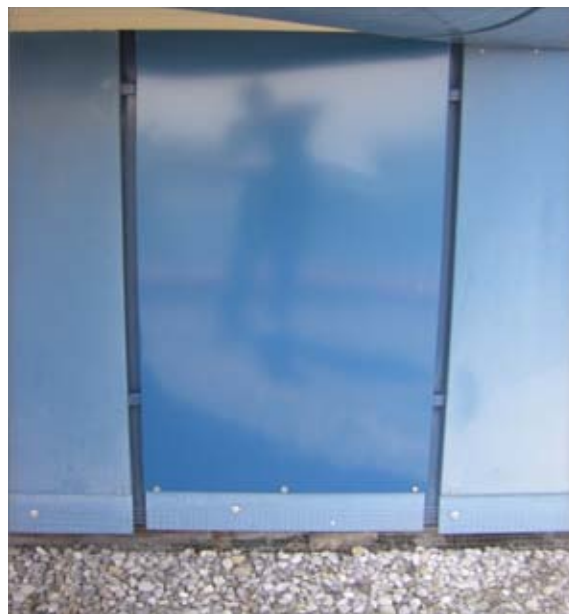
Bild 21: Detailaufnahme Metallfassade blau pulverbeschichtet mit Reinigungsmusterfläche
