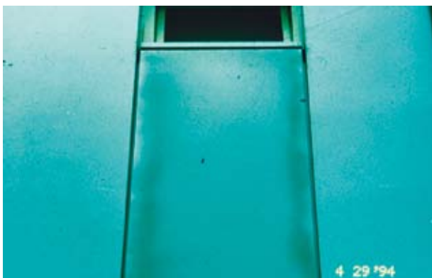
Bild 6: Bilderrahmeneffekt bei Metallic-Beschichtungen
